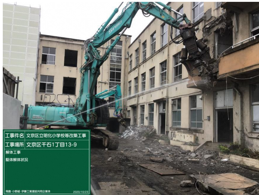
建物解体及び散水養生 参考写真(1期解体)
