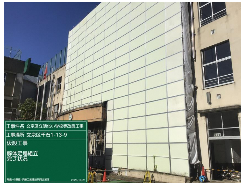
防音パネル養生 参考写真(1期解体)
