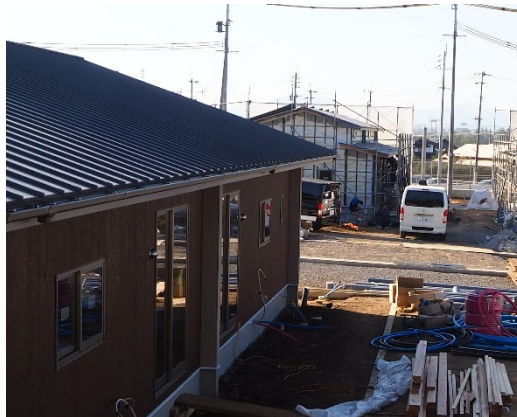
建設中の災害公営住宅 畑中団地 (畑中団地の隣)
