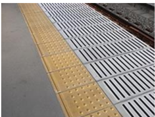
内方線付点状ブロック
