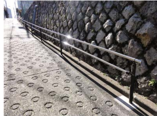
急な坂道への手すりの設置
