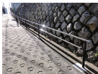
急な坂道への手すりの設置
