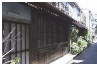
路地沿いに建つ木造の長屋(根津)
