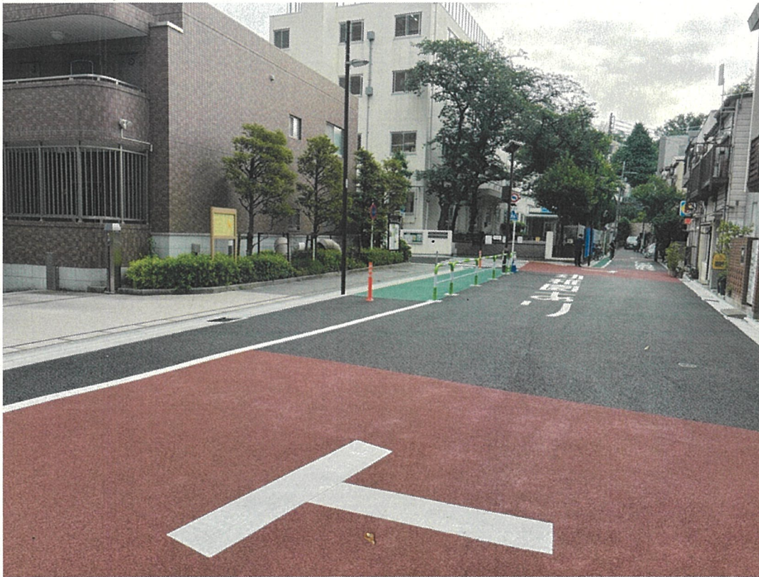
根津小学校（電線共同溝）
