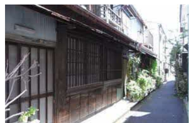
路地沿いに建つ木造の長屋(根津)
