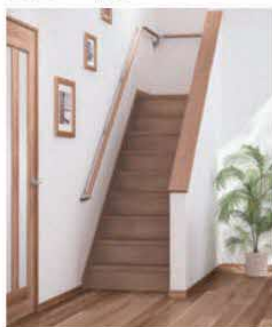
■手すりの設置
