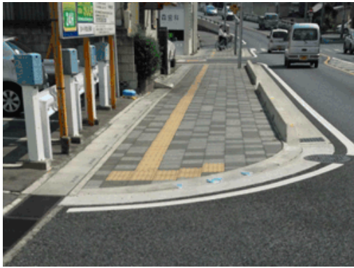
バリアフリー化された歩道
