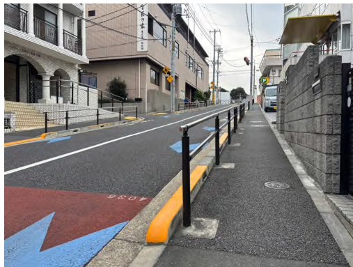
急な坂道への手すりの設置
