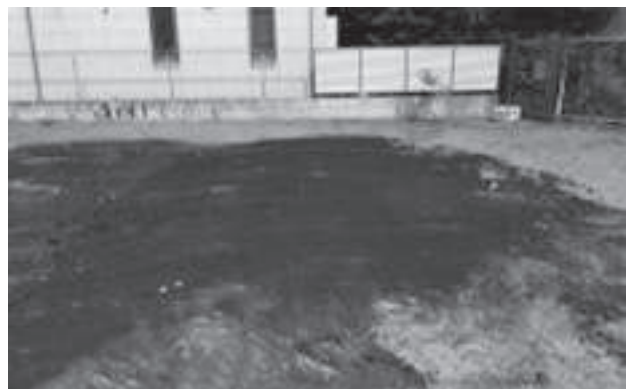
写真 16 埋戻し復旧状況（西から）
