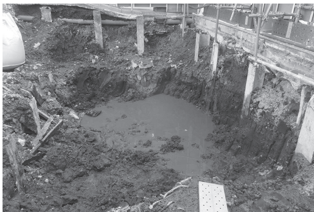
写真 28 試掘坑 3 全景（北から）
