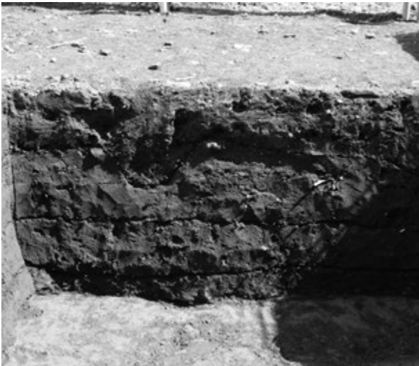
写真5 試掘坑南壁（北から）
