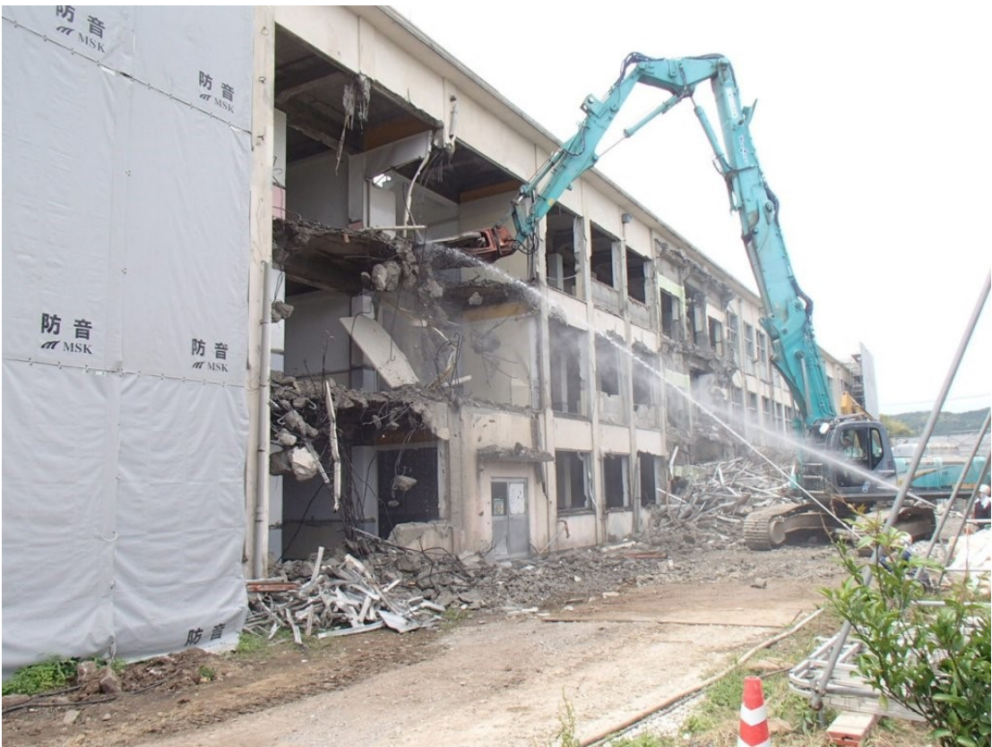
建物解体及び散水養生 参考写真
