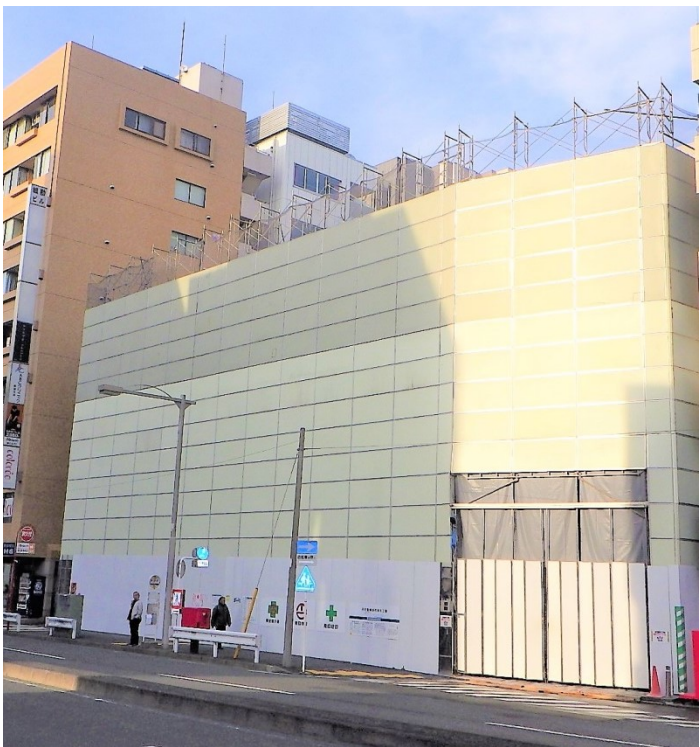
防音パネル養生 参考写真
