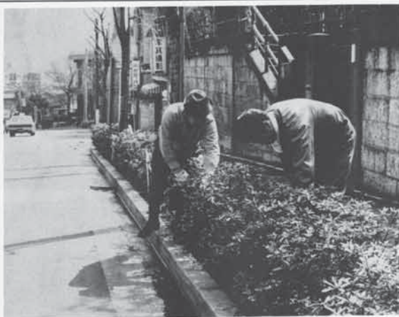
区道に緑を(つつじの植栽工事)
