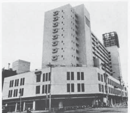
竣工した江戸川橋再開発ビル
