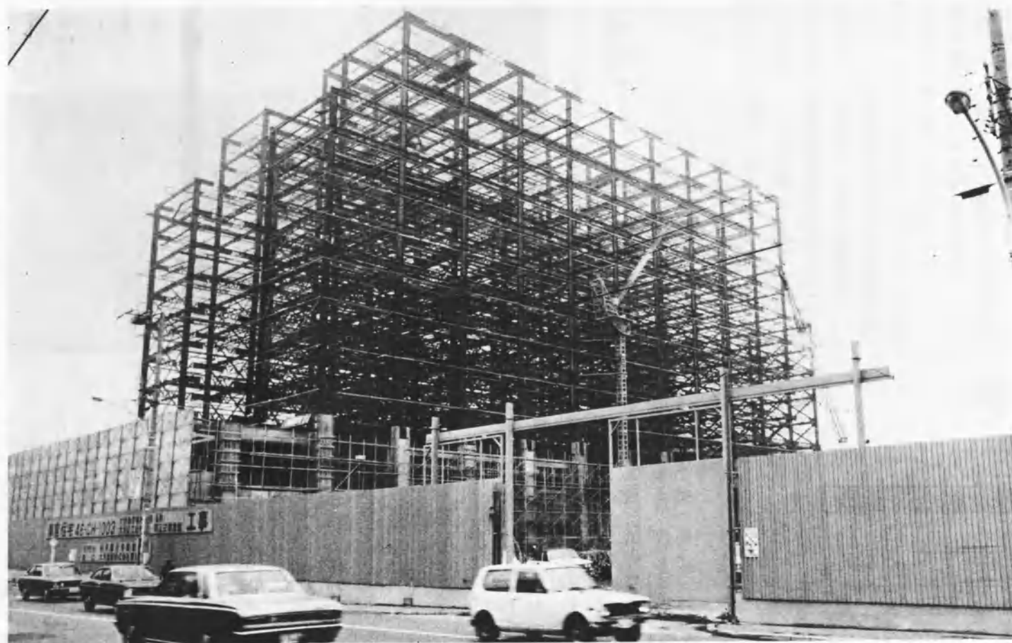
49年4月開設を目指し工事が進む、旧神明町車庫跡
