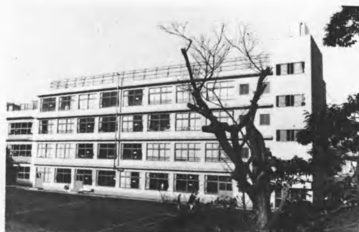
(林町小老朽鉄筋校舎改築)
