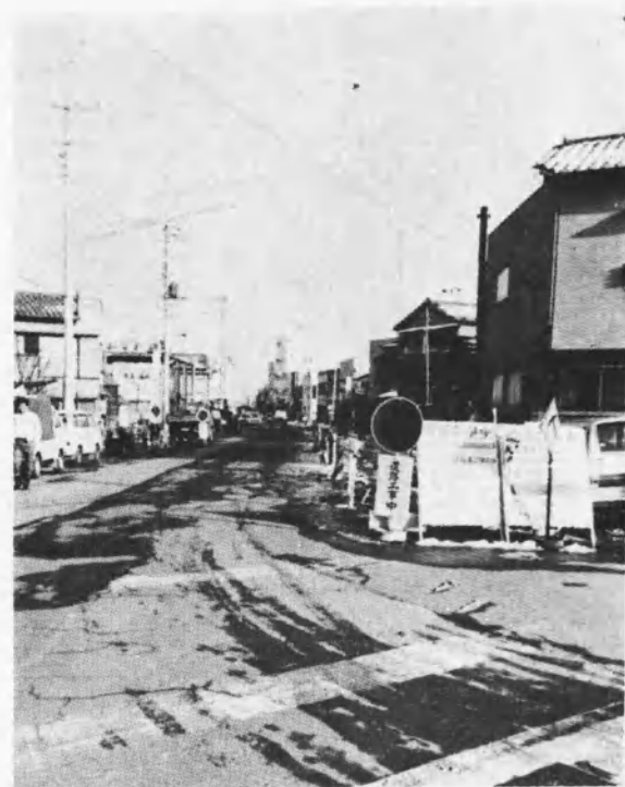
(向丘拡幅工事)
