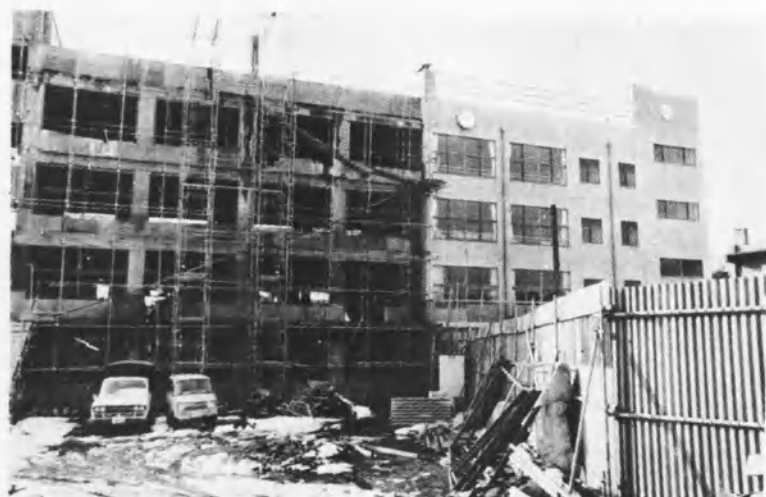
(文林中学校校舎改築工事)
