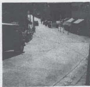
拡幅された区道(現在仮工事中)
