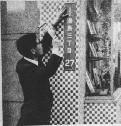
街区表示板の取り付け作業
