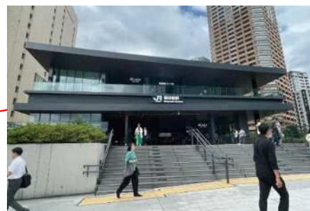
JR飯田橋駅西口駅舎の改良
