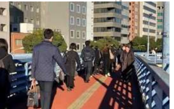
飯田橋歩道橋（階段部・歩行部）
