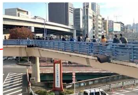
飯田橋歩道橋
