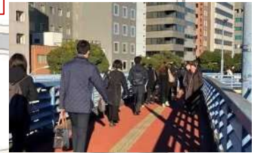
飯田橋歩道橋（階段部・歩行部）
