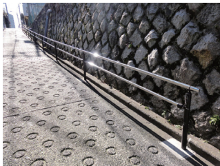
急な坂道への手すりの設置
