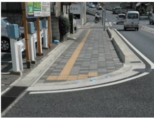
バリアフリー化された歩道
